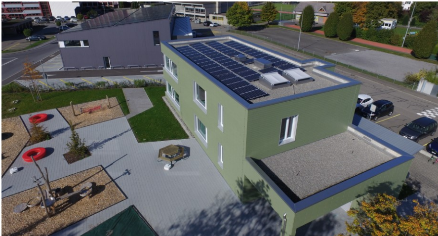
Kindergarten Riedland und Feuerwehrdepot mit Photovoltaikanlage auf dem Dach
